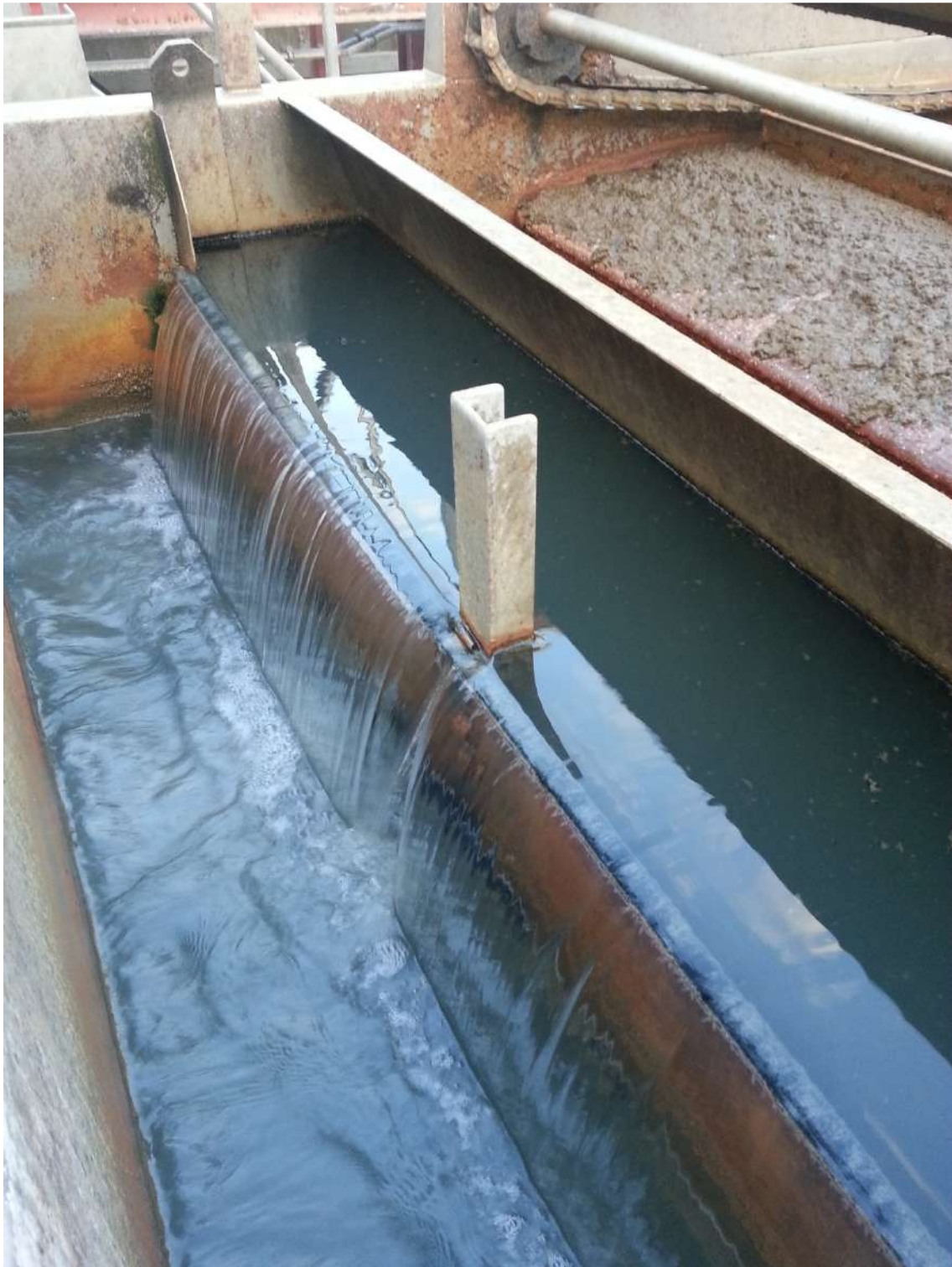
Picture 2 : Initial stage of flotation after of the improvements of the equipment ( water presurization with air to create micro-bubbles to float solids and emulsions). Aplicacion de coagulante / antiemulsionante para romper las emulsiones lácteas y separar las grasas y natas del vertido, para después poder agruparlas en la etapa de floculación. Reduction more than 70% of the initial inlet-COD flow in the majority of the cases (if ph is stabilisated).
